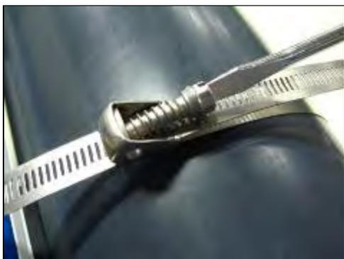
3-4) Verifier la tension du collier sur la conduite et effectuer un ajustement si nécessaire.
