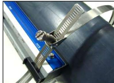
3-3) Tirez sur la courroie, placez la vis et serrez-la avec un tournevis.
